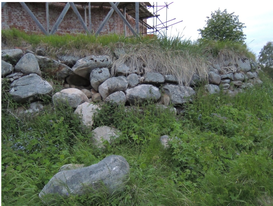
39. Участок подпорной стены с юго-востока. Вывалы валунов из кладки на середине высоты стены. Дата съемки: июнь 2014 г.
