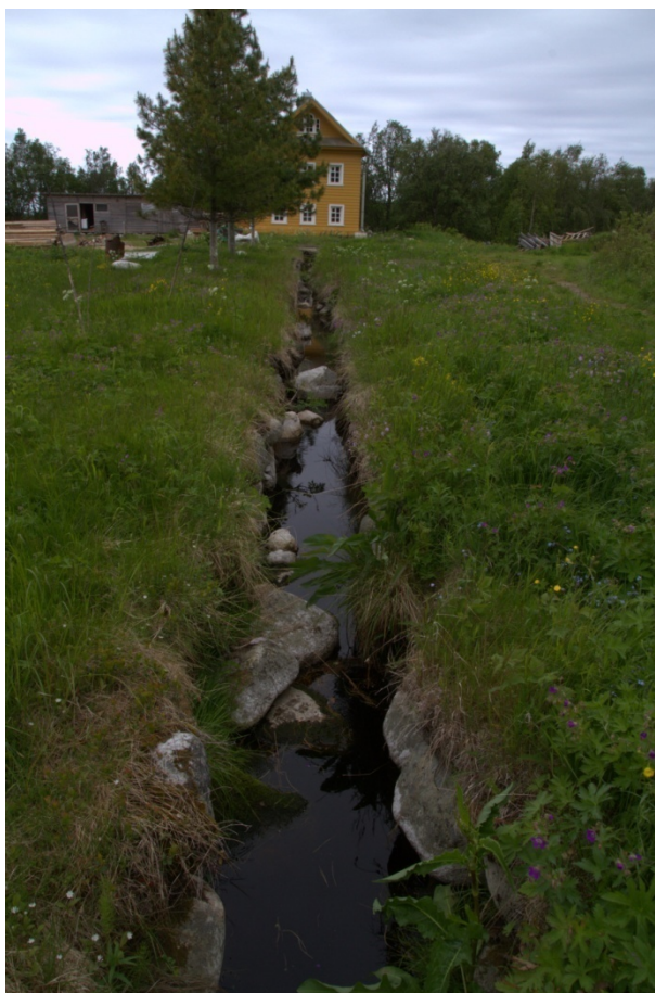
25. Ручей из Святого оз. в Белое море. Валунные стены канала. Повсеместные вывалы валунов, осыпание стен, заиливание дна. Дата съемки: июнь 2014 г.
