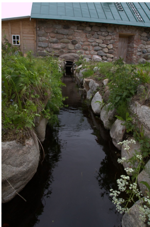
27. Западный рукав ручья, идущий через каменную баню. Валунные стены канала. Заиливание дна. Дата съемки: июнь 2014 г.
