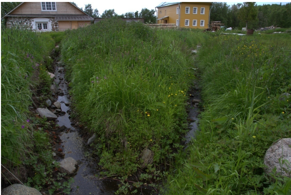
23. Пересечение каналов. Заиливание дна. Вывалы валунов, осыпание стен. Дата съемки: июнь 2014 г.
