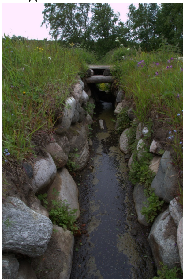
24. Канал со стенами из валунов. Заиливание дна. Выдавливание валунов из верхних рядов кладки. Заиливание дна. Дата съемки: июнь 2014 г..
