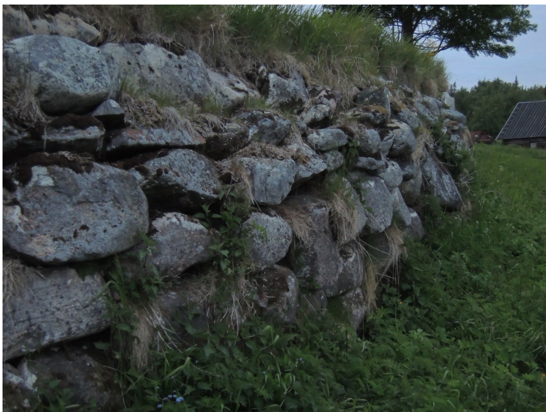
38. Участок подпорной стены с востока. Валунь не закреплены, кладка рассыпается. Выдавливание валунов на середине высоты стены. Дата съемки: июнь 2014 г.
