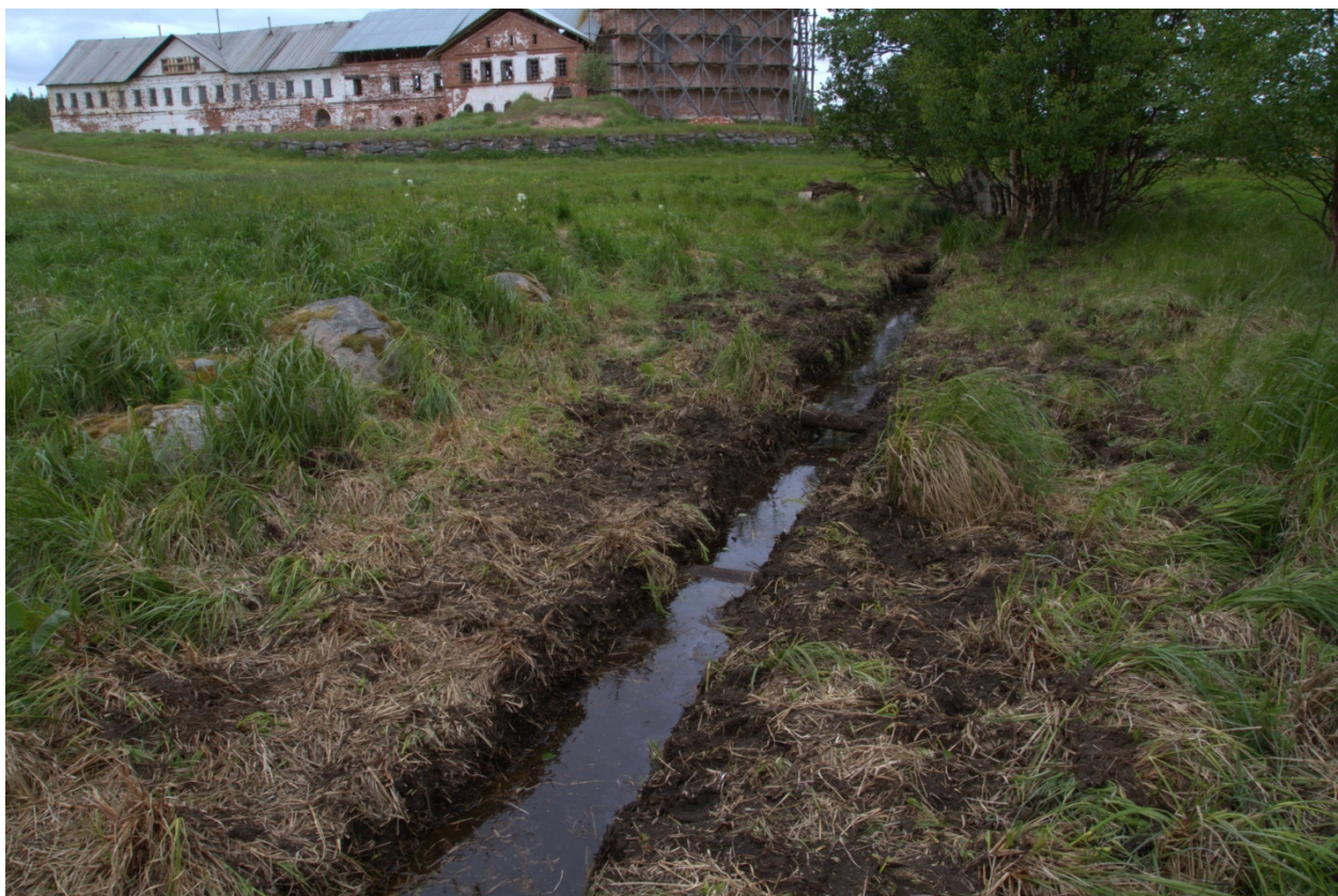
19. Недавно расчищенный участок канала. Осыпание стен. Заиливание дна. Дата съемки: июнь 2014 г.
