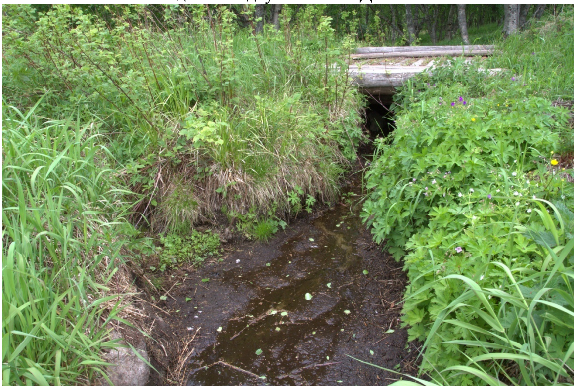
14. Недавно расчищенный участок канала. Осыпание стен. Заиливание дна. Дата съемки: июнь 2014 г.
