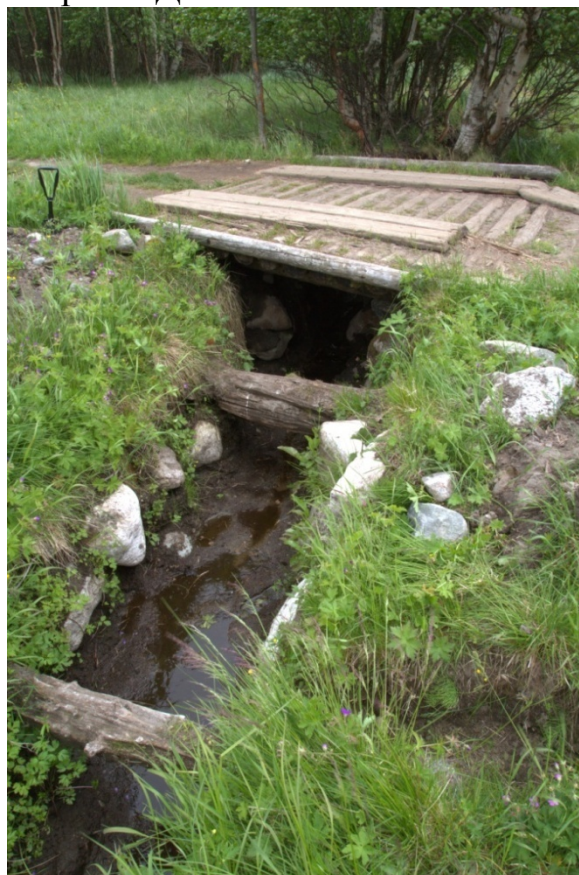
18. Канал со стенами из валунов, укрепленными бревенчатыми распорками. Заиливание дна. Вывалы валунов, осыпание стен. Дата съемки: июнь 2014 г.
