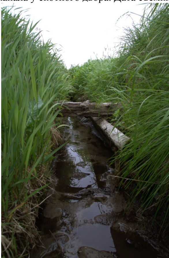
12. Недавно расчищенный участок канала. Осыпание стен. Заиливание дна. Дата съемки: июнь 2014 г.
