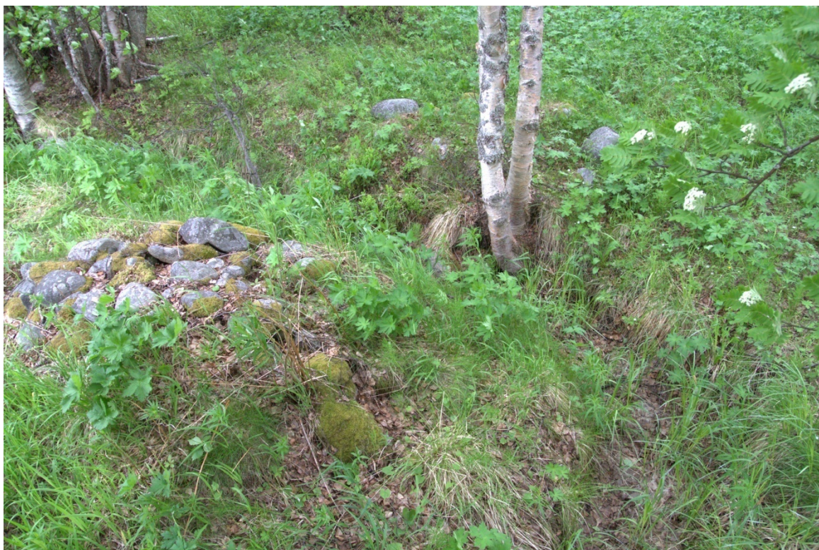
15. Частично заросший участок канала с укреплением откосов валунами и камнями на участке поворота. Дата съемки: июнь 2014 г.
