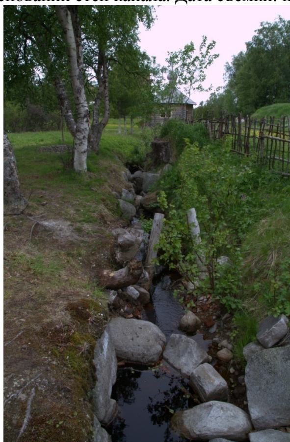
30. Участок канала ручья между Святым оз. и поздней деревянной часовней. Осыпавшиеся валунные стены канала. Сгнившие брёвна в основании стен канала. Дата съемки: июнь 2014 г.
