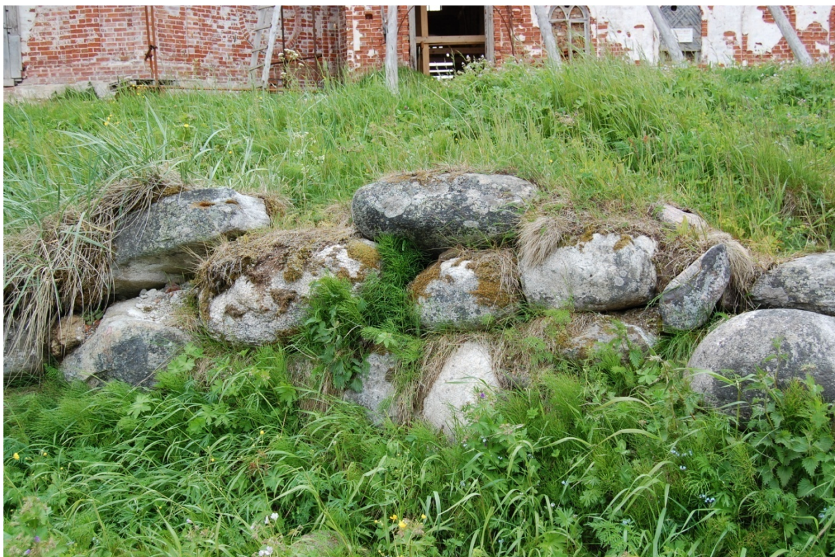
35. Участок подпорной стены с севера. Валуны не закреплены, кладка рассыпается. Стена заросла. Дата съемки: июнь 2014 г.
