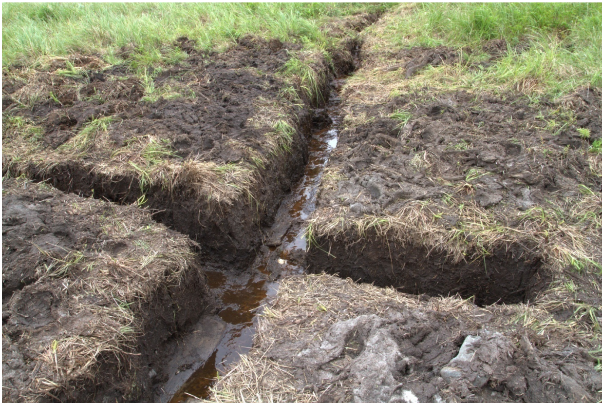
5. Недавно расчищенные участки каналов в месте пересечения. Заиливание дна. Дата съемки: июнь 2014 г.
