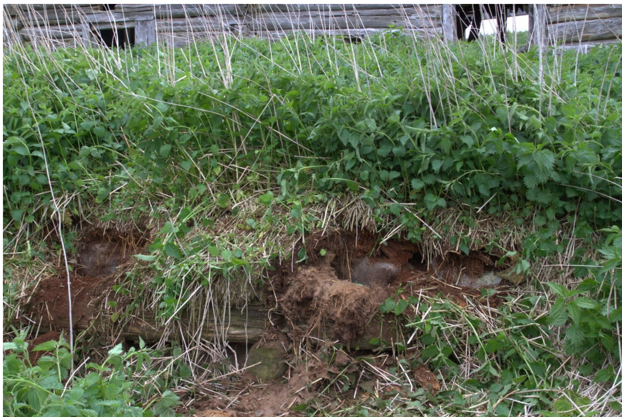
21. Валунная подпорная стена, укреплённая брёвнами. Дата съёмки: июнь 2014 г.
