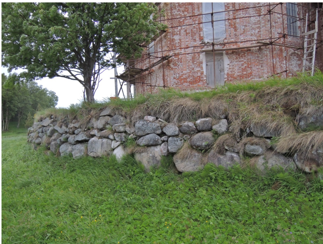
37. Участок подпорной стены с востока. Валунь не закреплены, кладка рассыпается. Выдавливание валунов на середине высоты стены. Дата съемки: июнь 2014 г.
