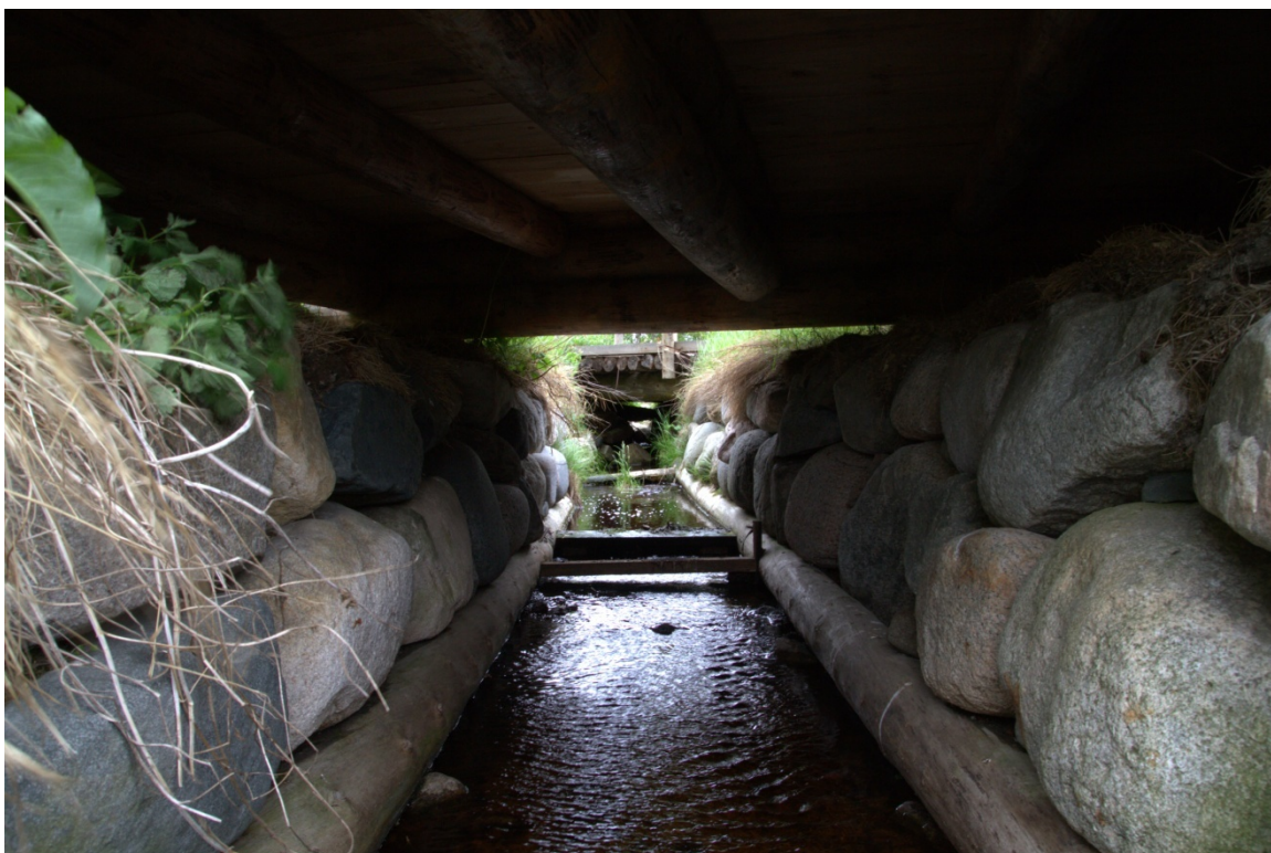
29. Восстановленный участок канала ручья под поздней деревянной часовней. Брёвна в основании стен канала. Дата съемки: июнь 2014 г.
