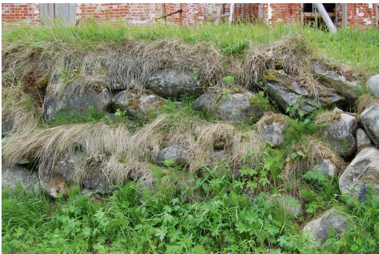
36. Участок подпорной стены с севера-востока. Валуны не закреплены, кладка рассыпается. Стена заросла. Дата съемки: июнь 2014 г.
