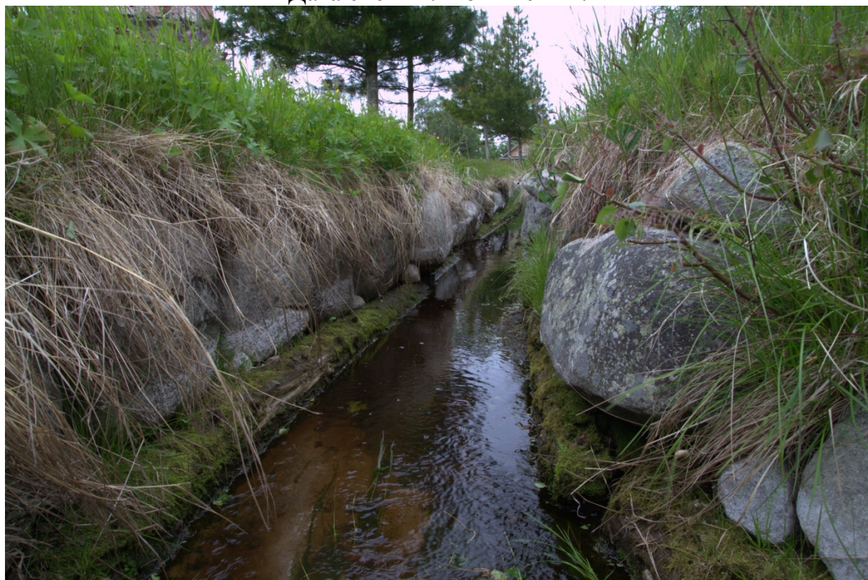
34. Участок канала высотой в валун. Гниющие брёвна в основании. Дата съёмки: июнь 2014 г.
